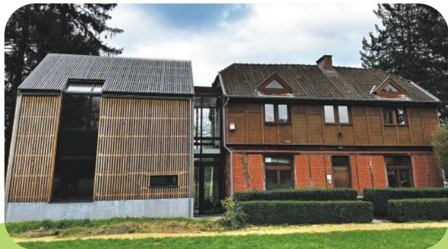
Photo des travaux au 19 novembre 2024
